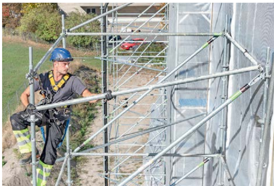
Hier entsteht ein Gerüstturm, der das Hauptgerüst bei starkem Wind stabilisiert.
